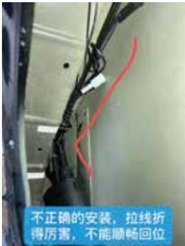
13.不正确的安装, 拉线折得厉害, 不能顺畅回位
