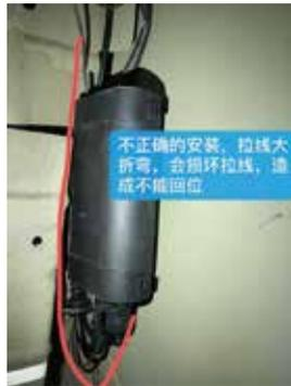
14.不正确的安装, 拉线大折弯, 会损坏拉线, 造成不能回位
